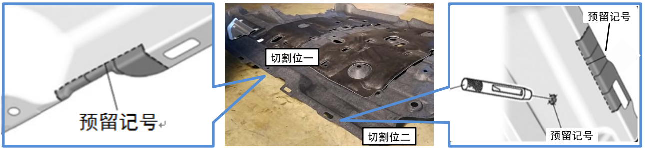
6. 车底防护板两处预留记号的位置切割掉（不切割安装支架时会与车底防护板有干涉）
